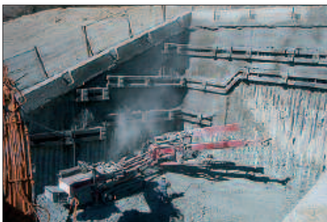
Paratie Tirantate di contenimento imbocco galleria di S. Giuliano di Puglia
