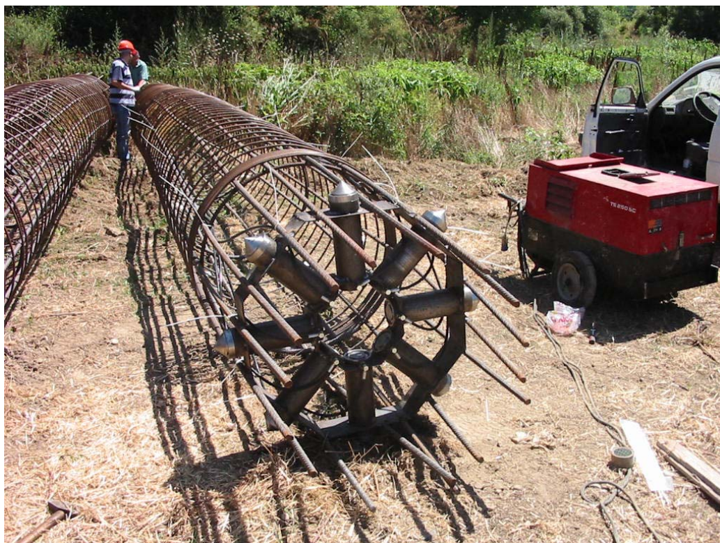
Applicazione reale del sistema TFEG su pali di grande diametro
