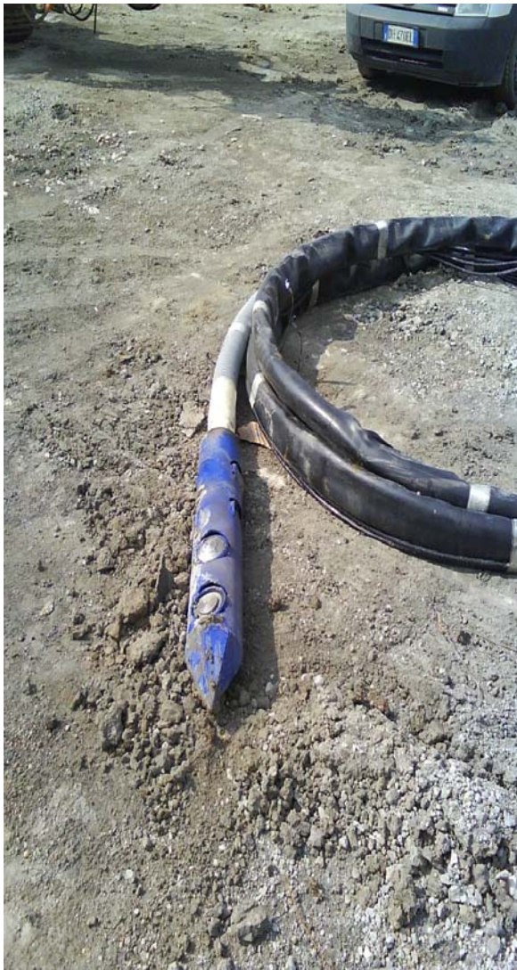
Sistema TFEG® - Applicazione su Tirante Attivo
